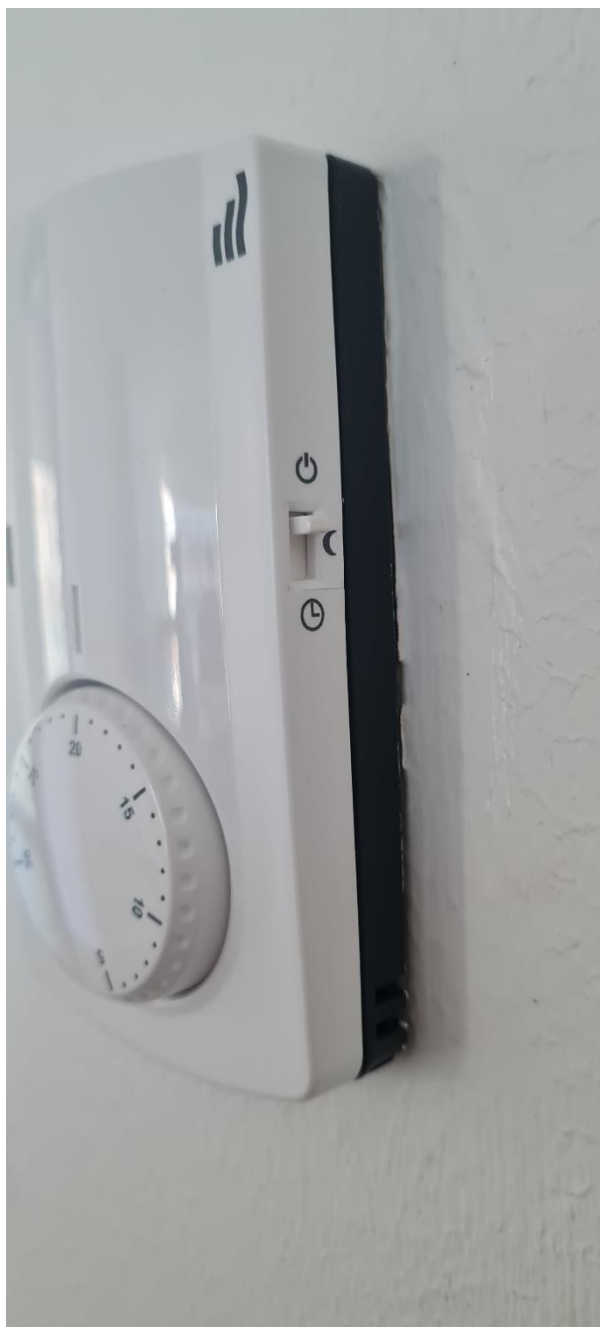
BILD: Rumstermostaten är felinställd då den ska vara inställd på klockan.
