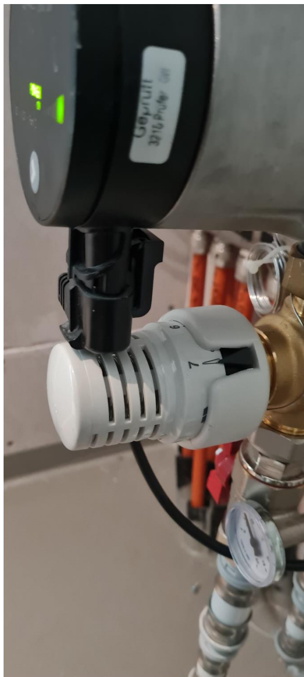
BILD: Termostathuvudet är felinställt då den är max öppen.
